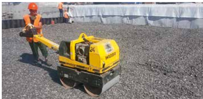
Рис. 8. Пример выполнения работ с использованием виброкатка
